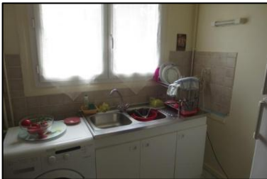
Photo N° 1005 ECH-2 -RDC- Cuisine Murs Faïence+colle
