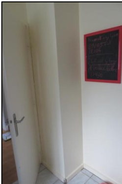
Photo N° 1010 ECH-3 -RDC- Cuisine Murs Plâtre+Peinture
