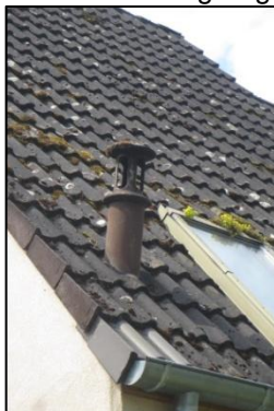
Photo N° 1020 AMIANTE CIMENT --Toiture Chapeau de ventilation
