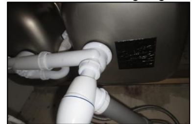
Photo N° 1008 ECH-4 -RDC- Cuisine Evier Plaque bitumineuse
